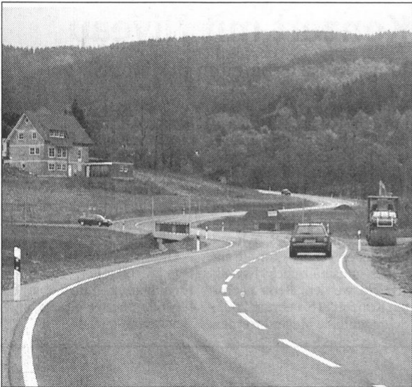
Die Umgehungsstraße schlängelt sich am Ort vorbei. Der Ortseingang (links) soll attraktiv begrünt werden. Foto: Eberts
